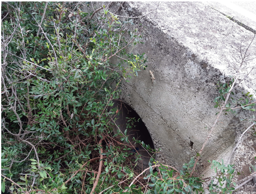
Foto 3: ATTRAVERSAMENTO 1, costituito da una tubazione in cemento diametro 600 (lato di monte)
