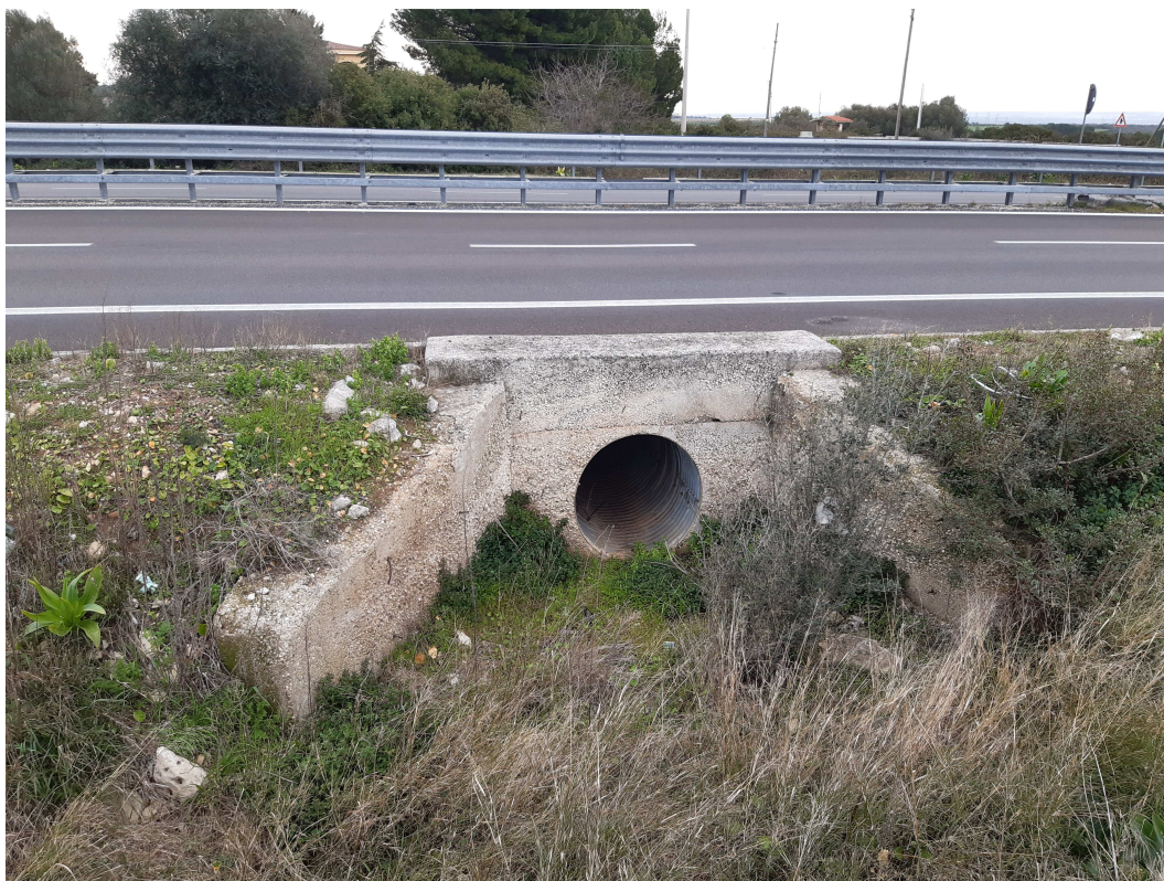
Foto 5: ATTRAVERSAMENTO 3, costituito da una tubazione in cemento diametro 1000 (lato di monte)
