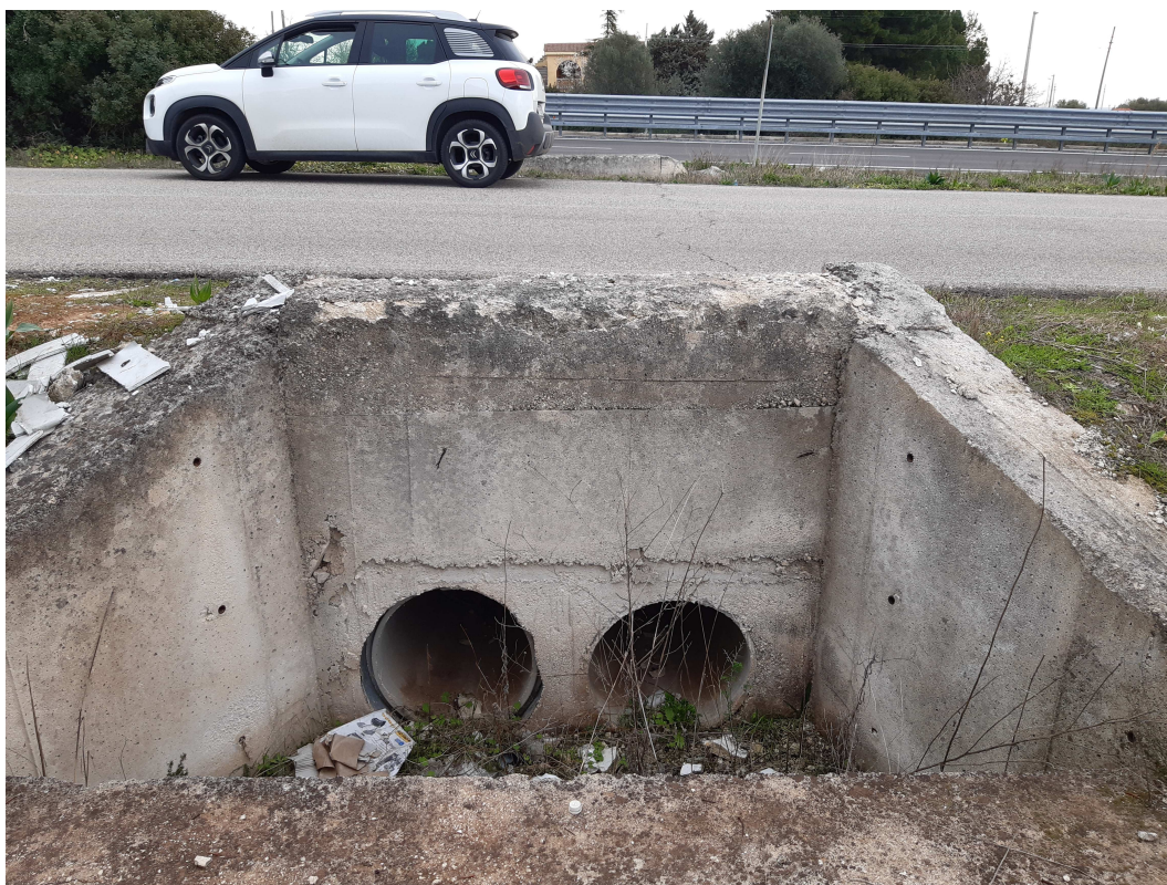
Foto 4: ATTRAVERSAMENTO 2, costituito da doppia tubazione in cemento diametro 600 (lato di monte)
