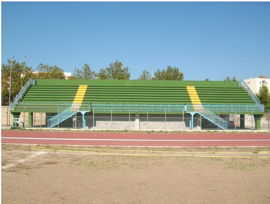
Vista frontale della gradinata spettatori di cui si prevede la copertura
