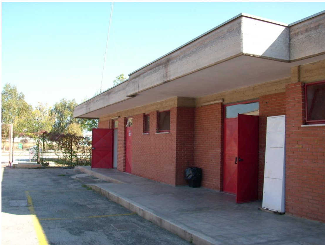
Il fabbricato adibito a spogliatoi e servizi
