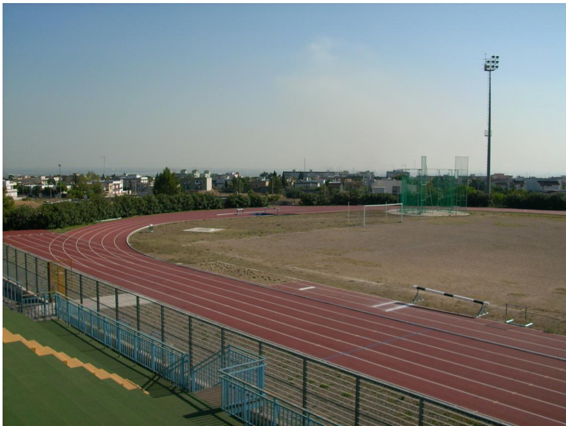
Vista d'insieme dello stadio per il calcio e l'atletica leggera (lato sud)
