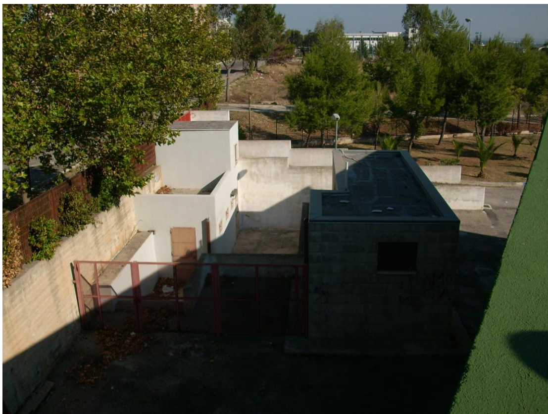
Vista d'insieme dei manufatti adibiti a biglietteria, locali tecnologici e servizi igienici spettatori
