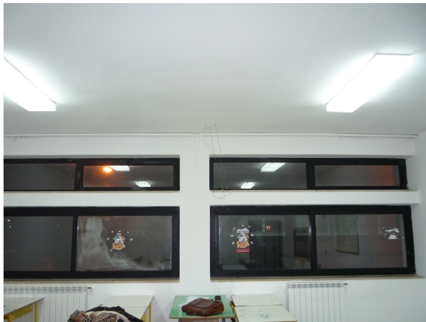
Foto 8: Aula – Particolare infissi esistenti
