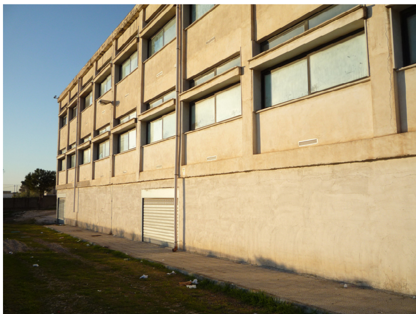
Foto 6: Accesso ai locali depositi
